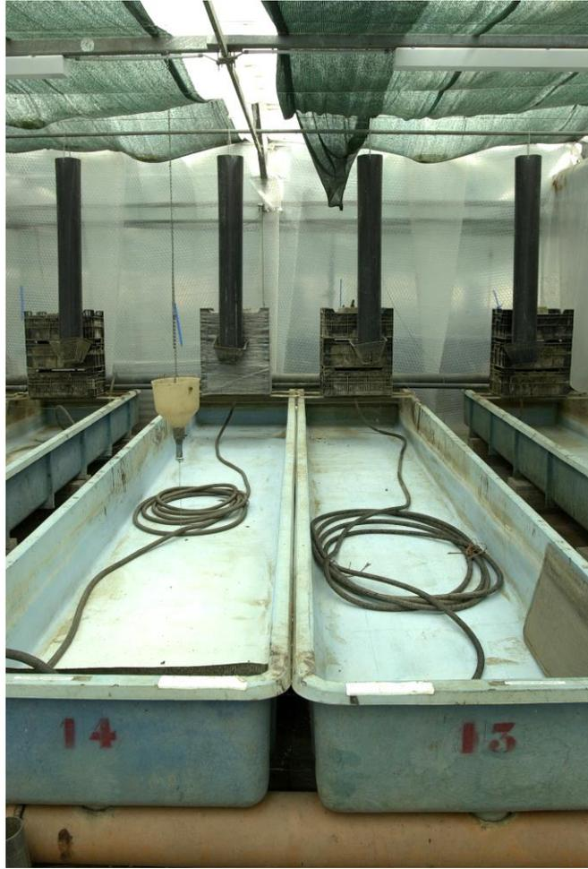
Photo 4 : Auges d'alevinage en circuit ouvert avec tour de dégazage et tuyau échangeur de chaleur
