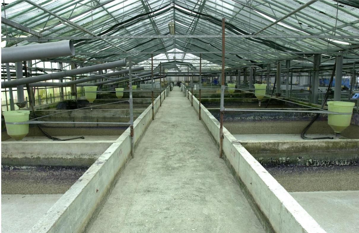
Photo 5 : Ensemble de bassins en béton de 20 m<sup>3</sup> avec nourrisseur pendulaire à la demande
