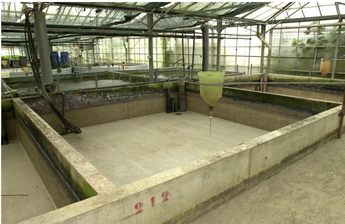
Photo 6 : Bassin en béton de 20 m<sup>3</sup> avec tour de dégazage et nourrisseur pendulaire
