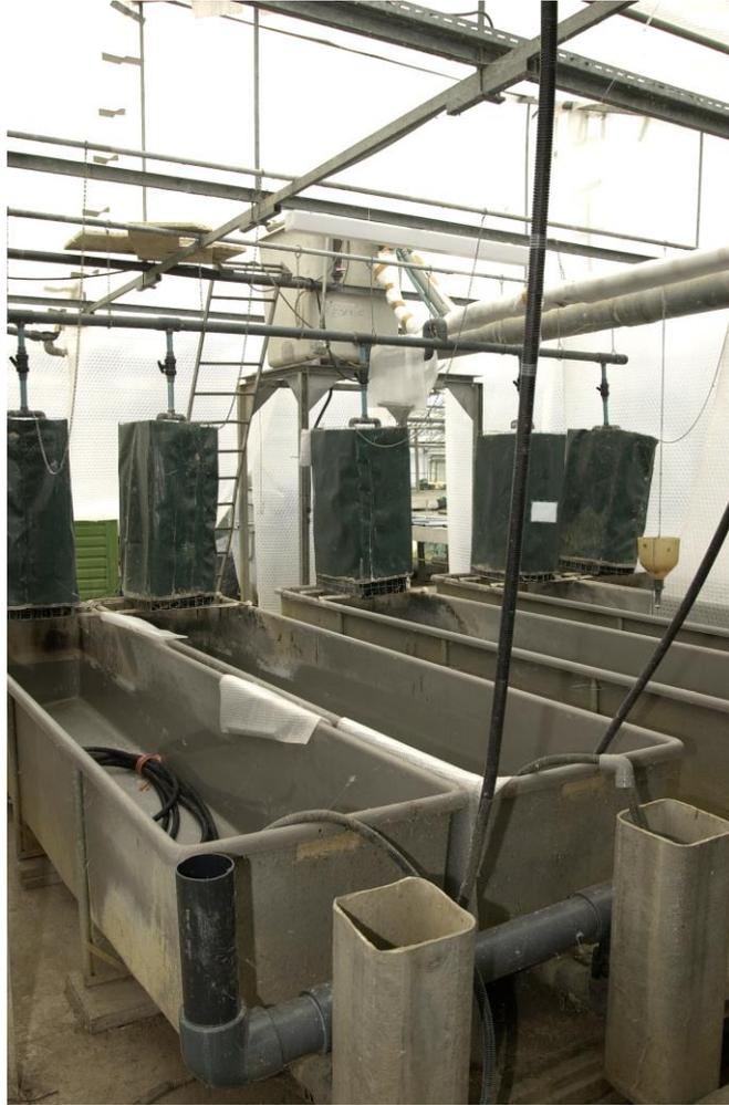
Photo 3 : Batterie de bassins du circuit fermé n° 3 (CF 3) avec tour d'épuration et château d'eau à l'arrière plan
