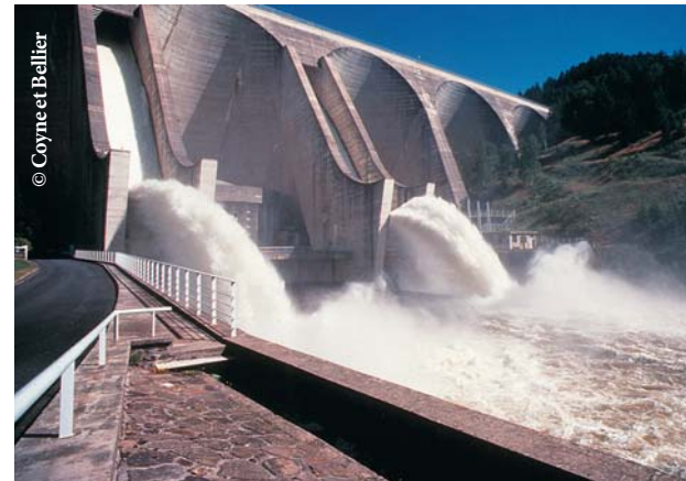
Le barrage de Grandval sur la Truyère, 1959, un exemple de l'élégance d'un barrage à voûtes multiples, hauteur 85 m.
