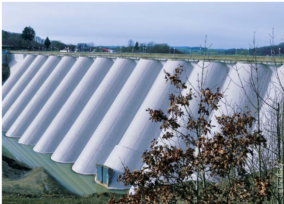
Le barrage de Pannecière (Nièvre), ouvrage à voutes multiples de 49m de haut, participe à la protection de Paris contre les inondations. Géré par l'Établissement Public Territorial de Bassin Seine Grands Lacs, il a fait l'objet en 2011-2013 d'un confortement destiné à en améliorer la sûreté.
