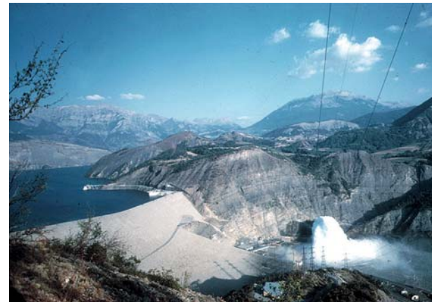
Barrage de Serre-Ponçon sur la Durance, 1962 EDF.
