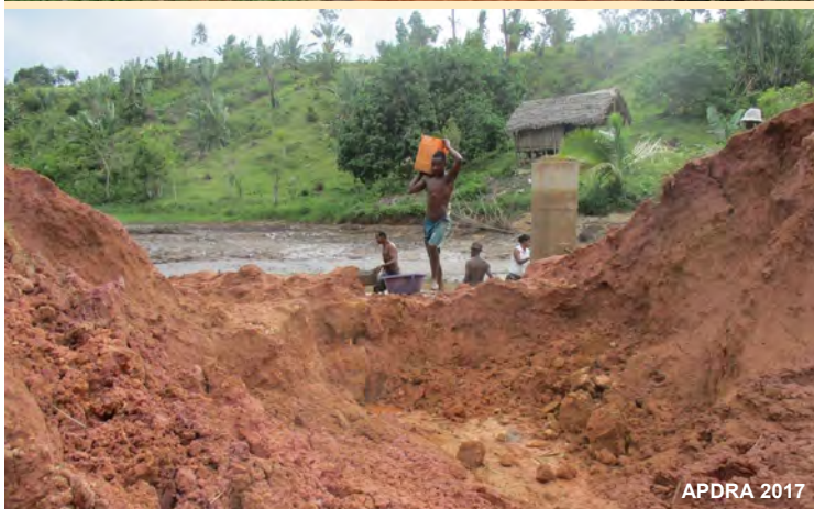
Reconstruction d'une digue endommagée par le cyclone
