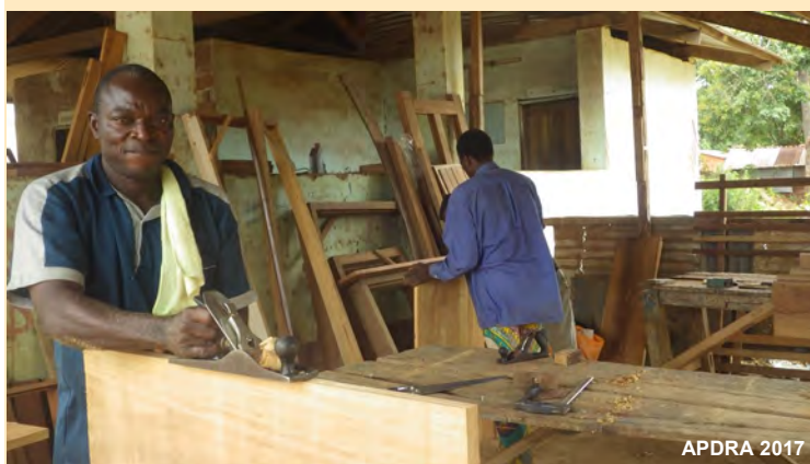
Confection de coffrages
