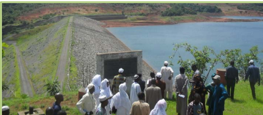
Photo 1. Visite des installations du barrage de Garafiri
