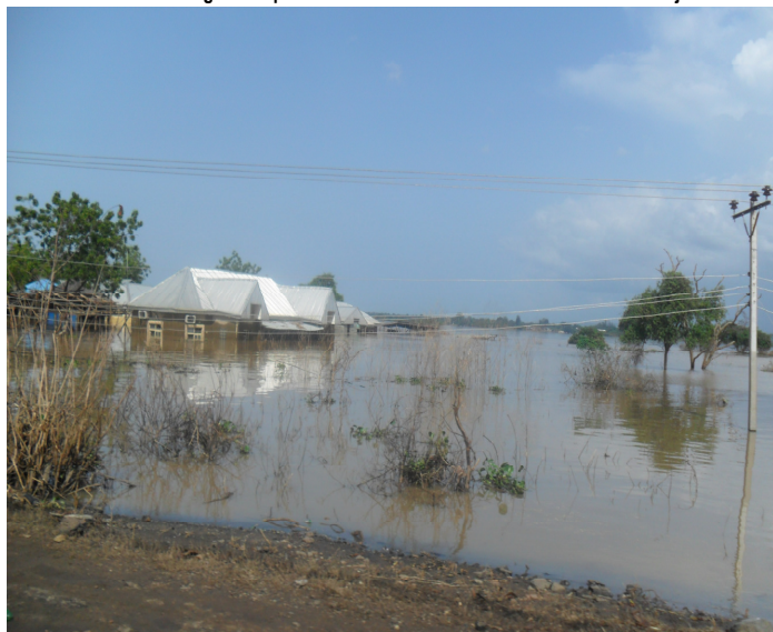
3 Planche3 : Maisons englouties par les eaux d'inondation dans la localité de Lokoja
